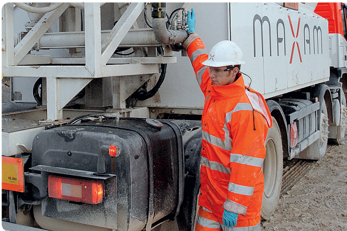
RIOXAM BK wird direkt am Einsatzort hergestellt
