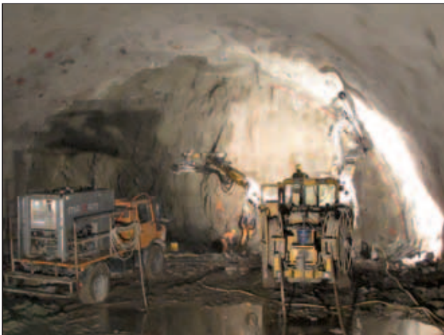
Abb. 4: Das Mischladegerät auf dem Trägerfahrzeug (MLG)
