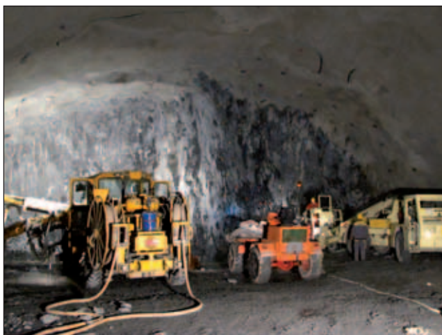
Abb. 5: Darstellung der mittig geteilten Kalotte der Maschinenkaverne
