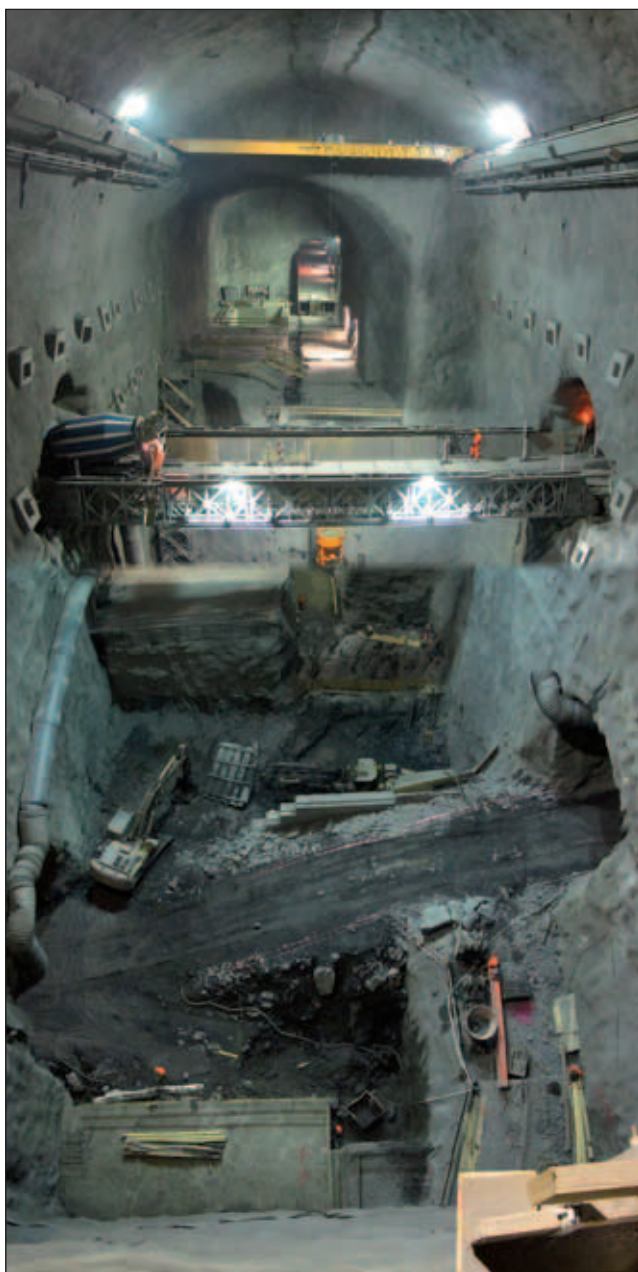
Abb. 7: Blick in die Maschinenkaverne vom Kalottenzugangsstollen
