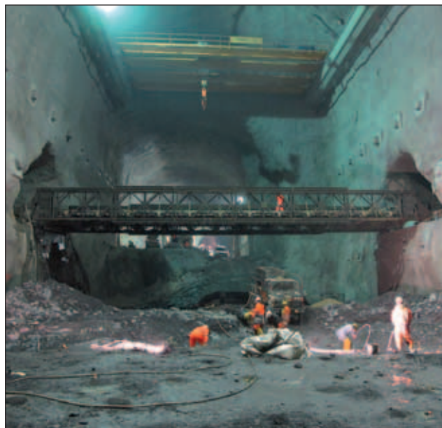
Abb. 6: Vorbereitung einer Strossensprengung
